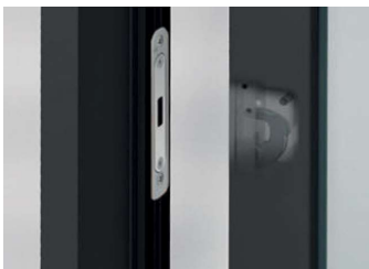
Zasuwnica hakowa w drzwiach tarasowych HS
