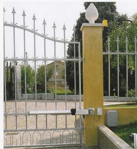
Przykładowa instalacja siłownika i niektórych akcesoriów: lampy, programatora i fotobarier.
